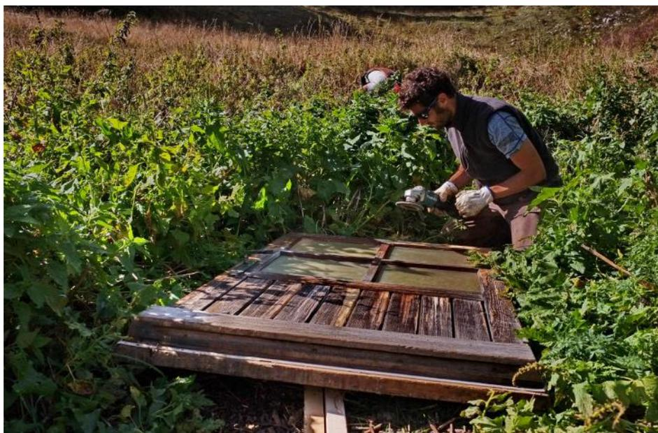
*Ponçage de la porte d'entrée de Tiolache pour mise en lasure*
