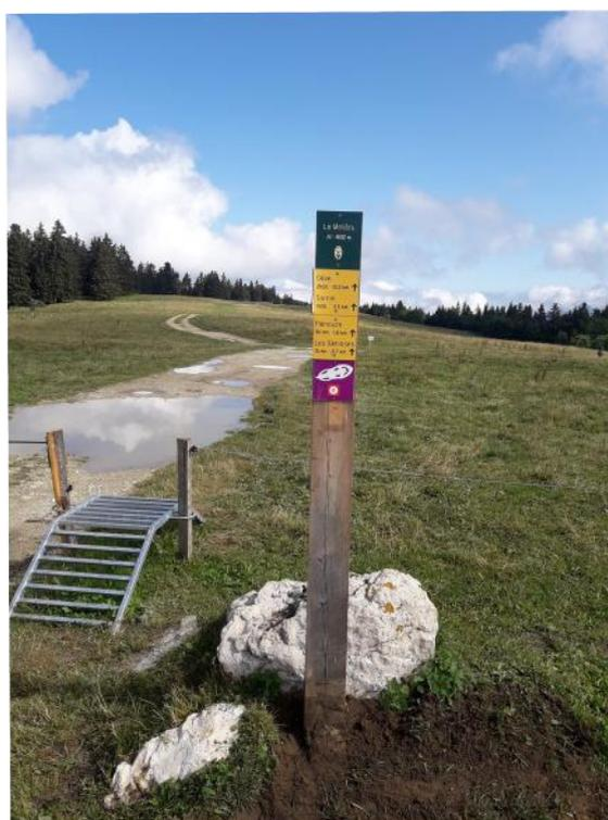
*Remise en état du poteau de signalétique au Fournel avec la signalétique pastorale et poteau remis en place à la molière (sur les alpages, les poteaux doivent être bien ancrés car les bovins vont venir s'y frotter)*
