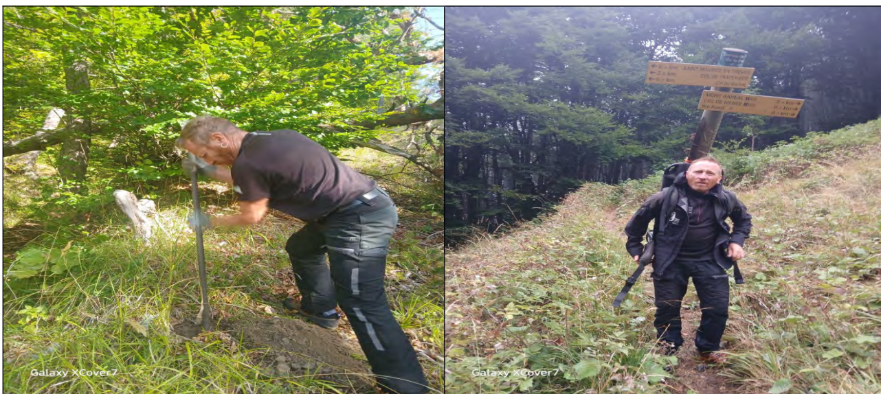
Portage et pose de poteaux de signalétique
